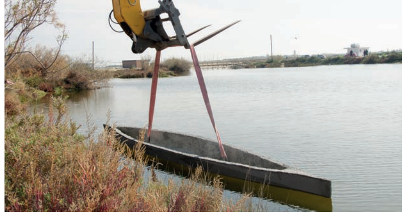
Beton kano suya indirilirken
